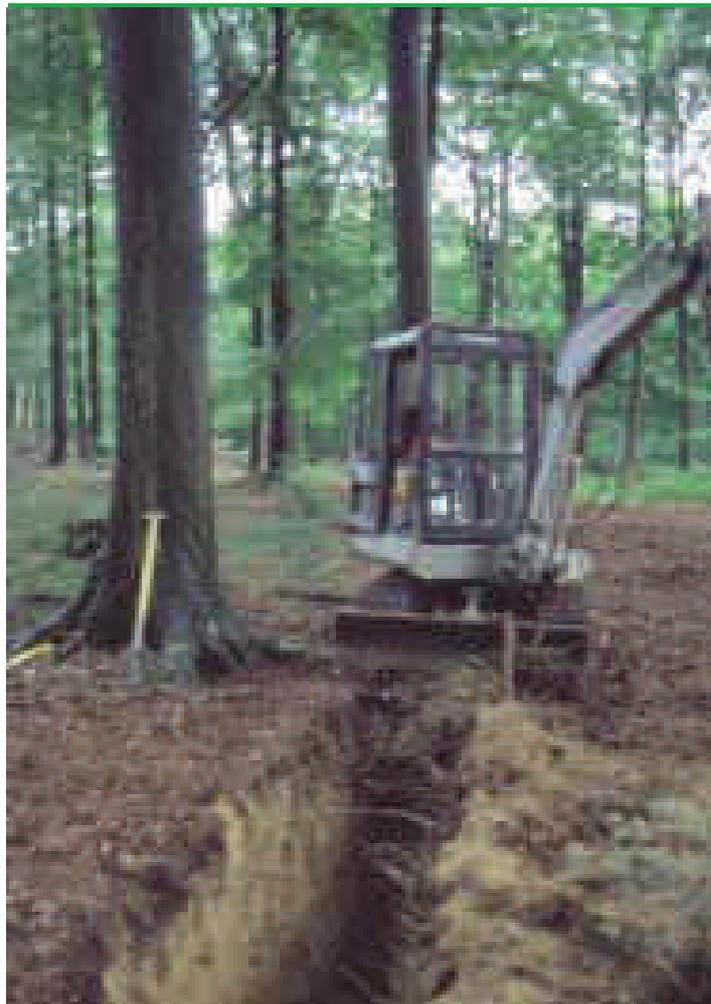
Bild 23: Anlage eines Wurzelgrabens
